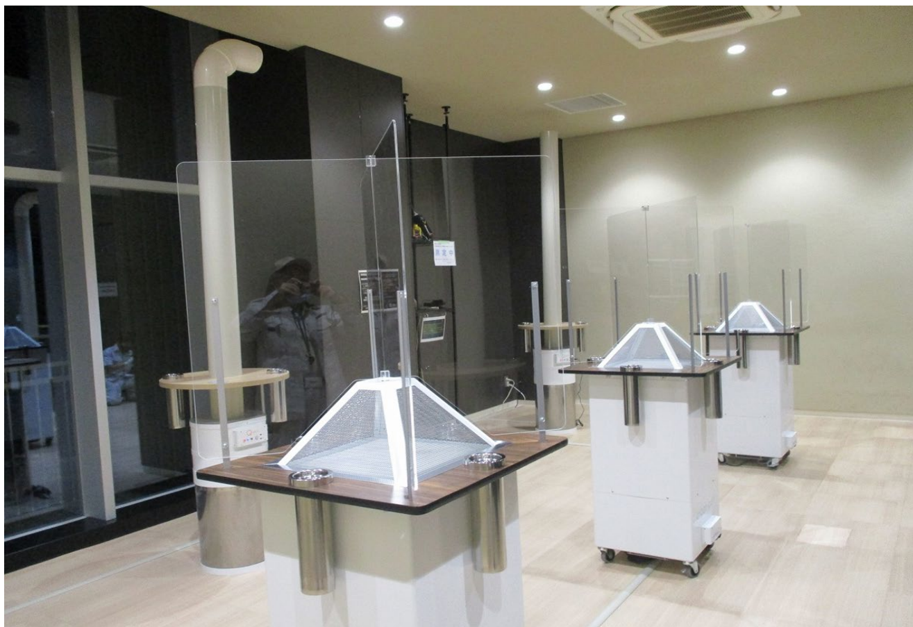
(物流倉庫 既存喫煙室の改善)
