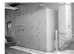
排水処理施設の臭気対策
